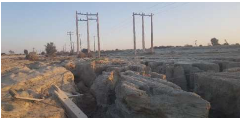
تخریب بسیار شدید و وسیع
