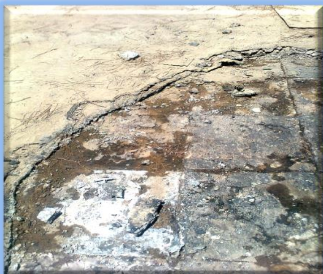
ایزوگام قبل از اجرا
