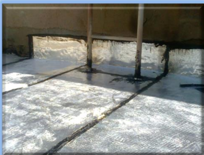
ایزوگام بعد از اجرا
