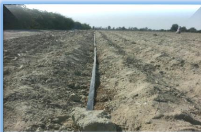
راه اندازی آبیاری تحت فشار
