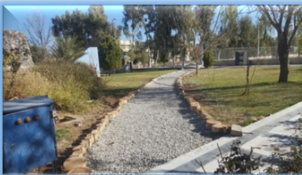
تصویر ۴- احداث مسیر در پشت اداره فضای
