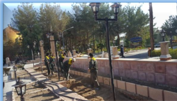
تصویر ۲- خاکبرداری و خاکریزی باغچه های تازه احداث شده اداره کار آفرینی
