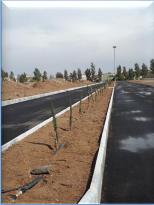
تصویر ۱۱- بلوار تازه احداث شده
