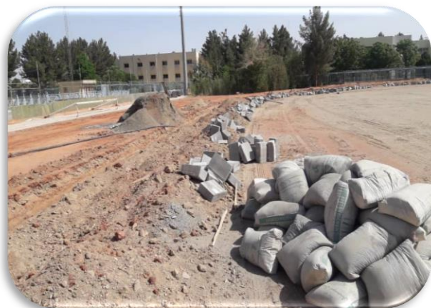
۴- عملیات نصب کانال جهت خروج آب در اطراف زمین
