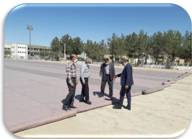
۸- عملیات پخش سلیس با دستگاه
