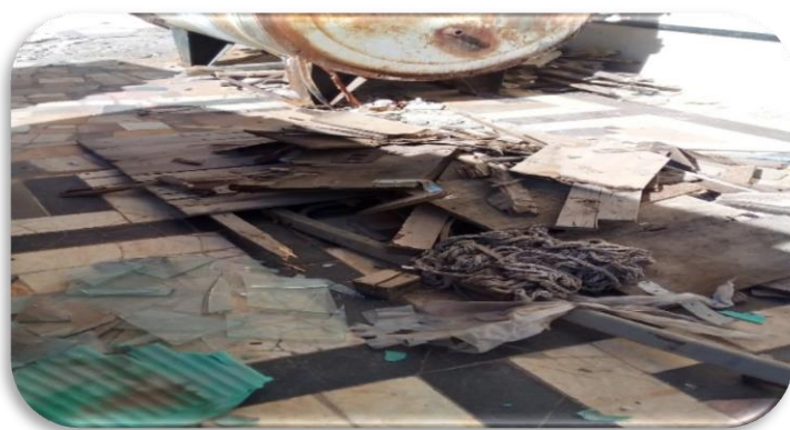
۲. تعویض و نصب درب های جدید اتاق سرها
