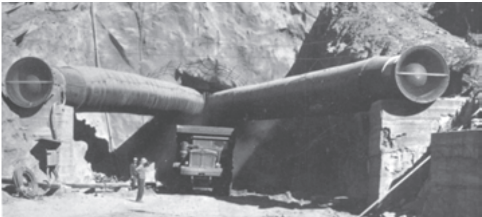
شکل ۳۷-۲- لوله‌های فلزی تهویه با اتصالات جوشکاری شده
