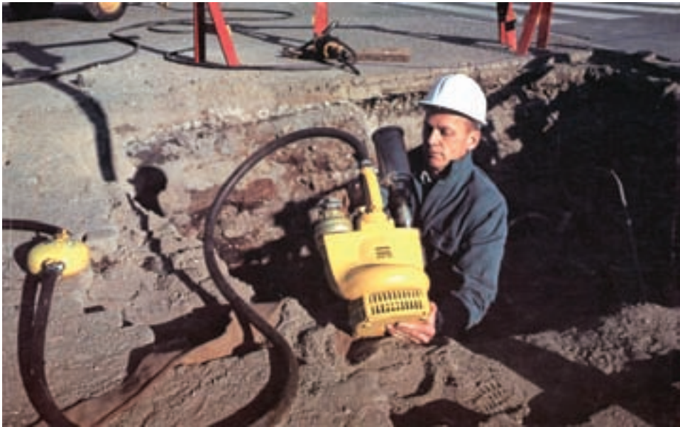
شکل ۱۸-۶- استفاده از پمپ با هوای فشرده
