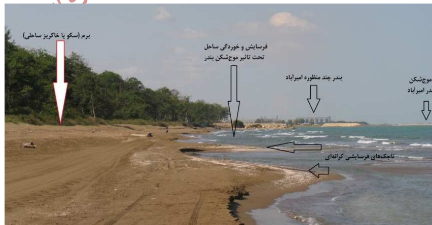
شکل ۱۰: نمایشی از اثرات توسعه و مطول ساختن موج شکن بندر چندمنظوره امیرآباد در تغییرات فرسایشی و خوردگی سواحل بخش خاوری آن که پیش از احداث این گونه سازه های مهندسی از نوع سواحل رسوب گذاری بوده است. منبع: پژوهشگر، شهر یورماه ۱۳۹۶.
