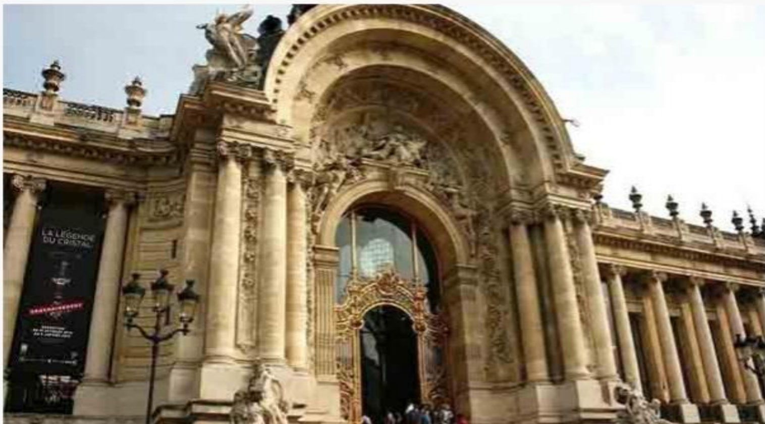
نمای خارجی عمارت
